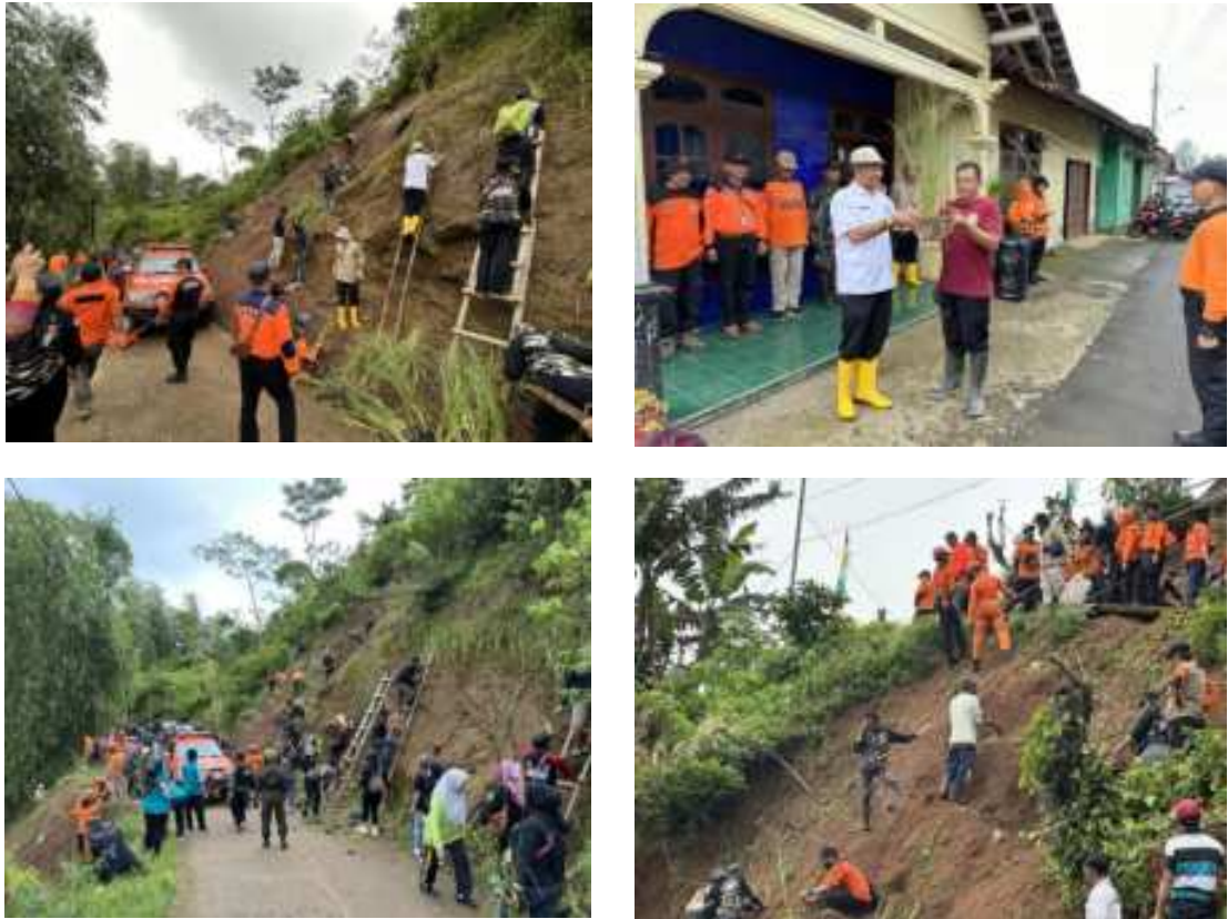
Gambar 3.2 Penanaman rumput vetiver untuk mencegah longsor pada tebing
